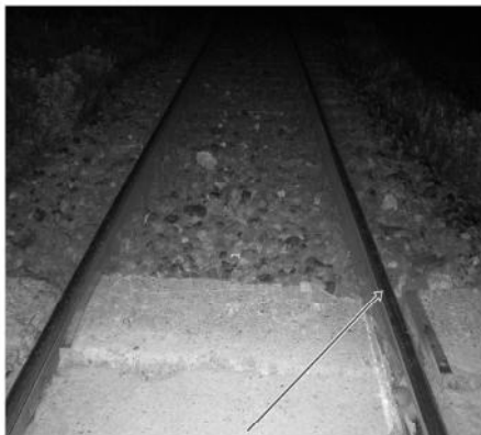
Foto 4 : Locul unde roțile boghiului deraiait s-au urcat înapoi pe calea de rulare
